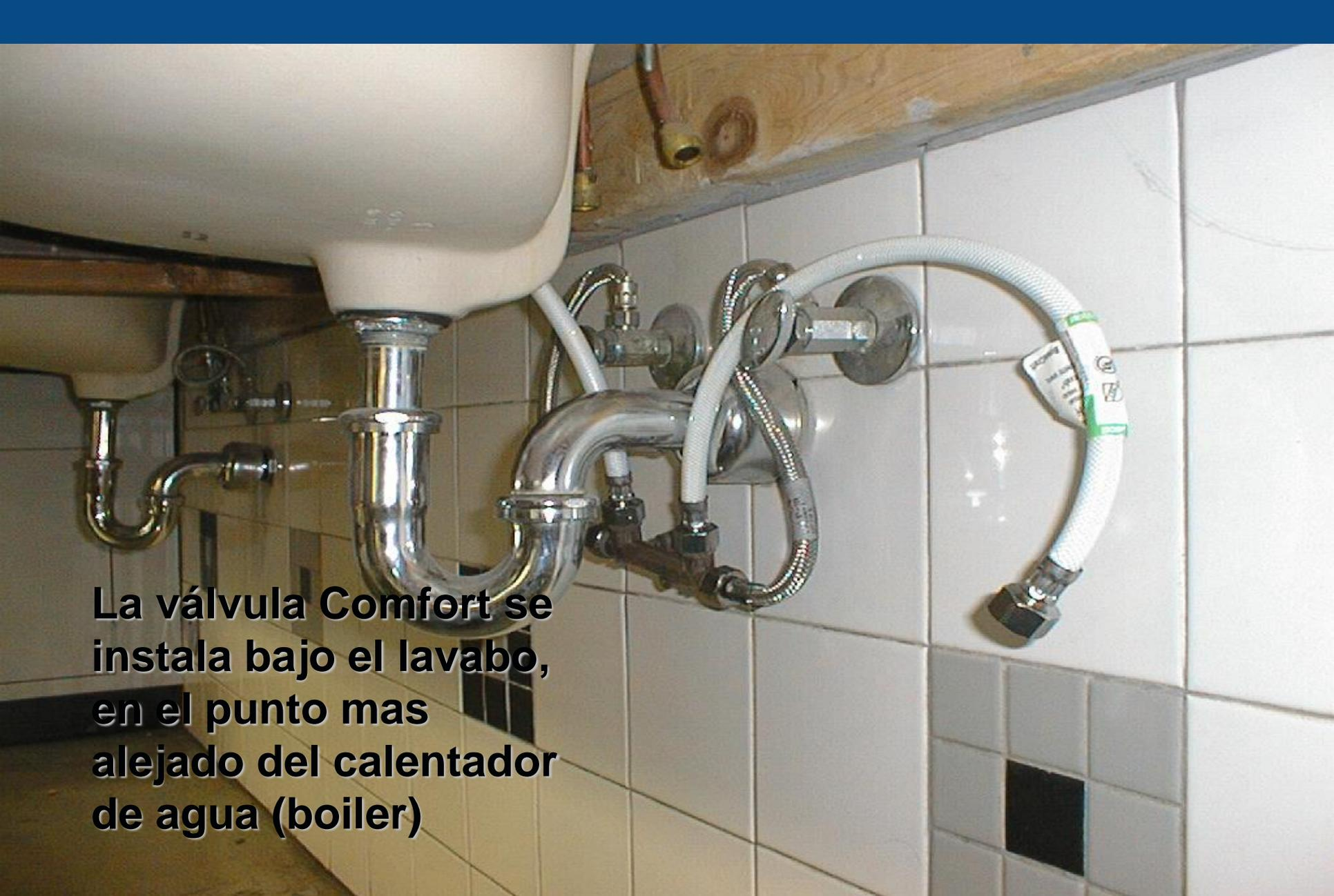
**La válvula Comfort se instala bajo el lavabo, en el punto mas alejado del calentador de agua (boiler)**
